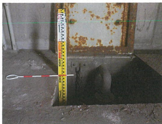
写-1 スラグ貯留棟沈砂槽深さ
