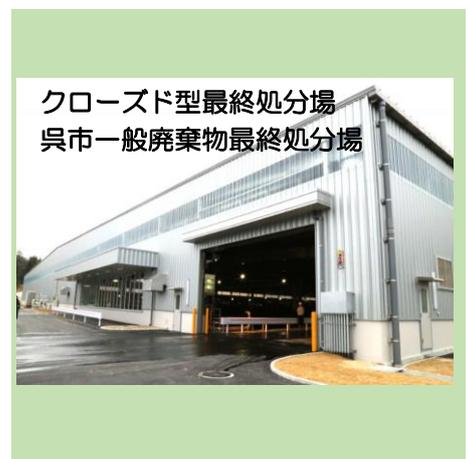
周辺環境に配慮したクローズド型(被覆型)最終処分場。雨水が流入しないため、浸出水処理施設は小規模となり、処理水は下水放流する。
