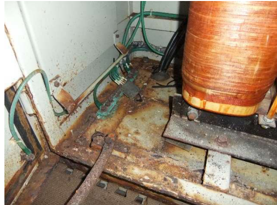
盤内部（底面）の腐食
