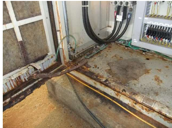
扉部分の腐食（開閉不良）
