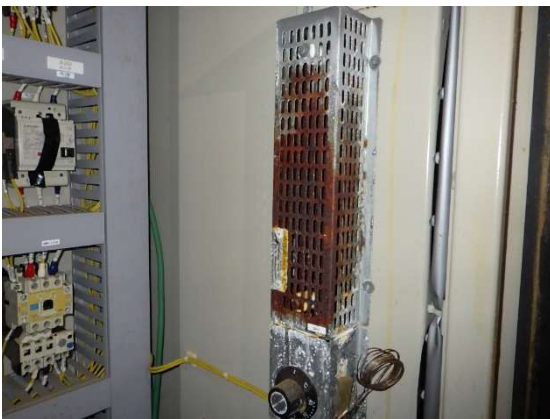
盤内部品の発錆
