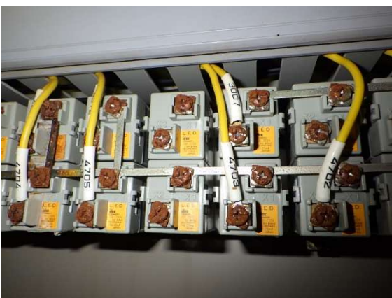
盤内部品の発錆
