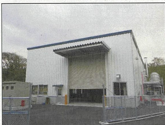
施設の外観（全景）
