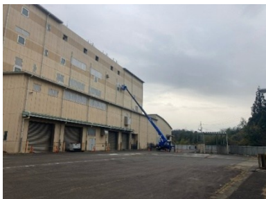
工場棟ダイオキシン類除染養生の状況
