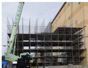
工場棟解体ヤード設置状況
