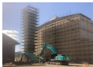
計量棟上屋解体状況
