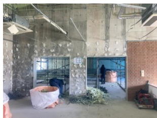
管理棟内装解体状況
