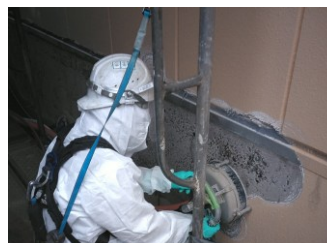
工場棟外壁石綿除去状況
