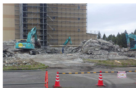
管理棟解体状況
