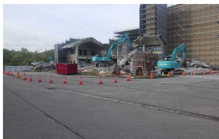
管理棟解体状況
