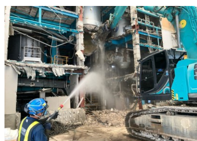
工場棟 機械設備解体状況
