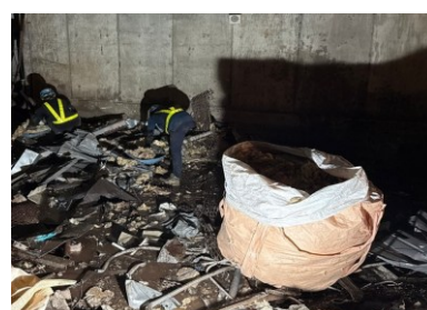
工場棟 解体材分別状況
