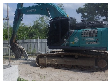
車庫棟 基礎（床版）解体状況
