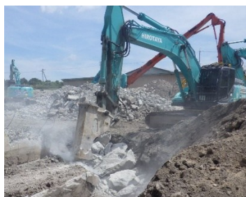
煙突棟 煙突基礎解体状況
