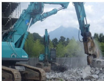
洗車棟 基礎解体撤去状況
