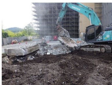
管理棟 基礎解体状況
